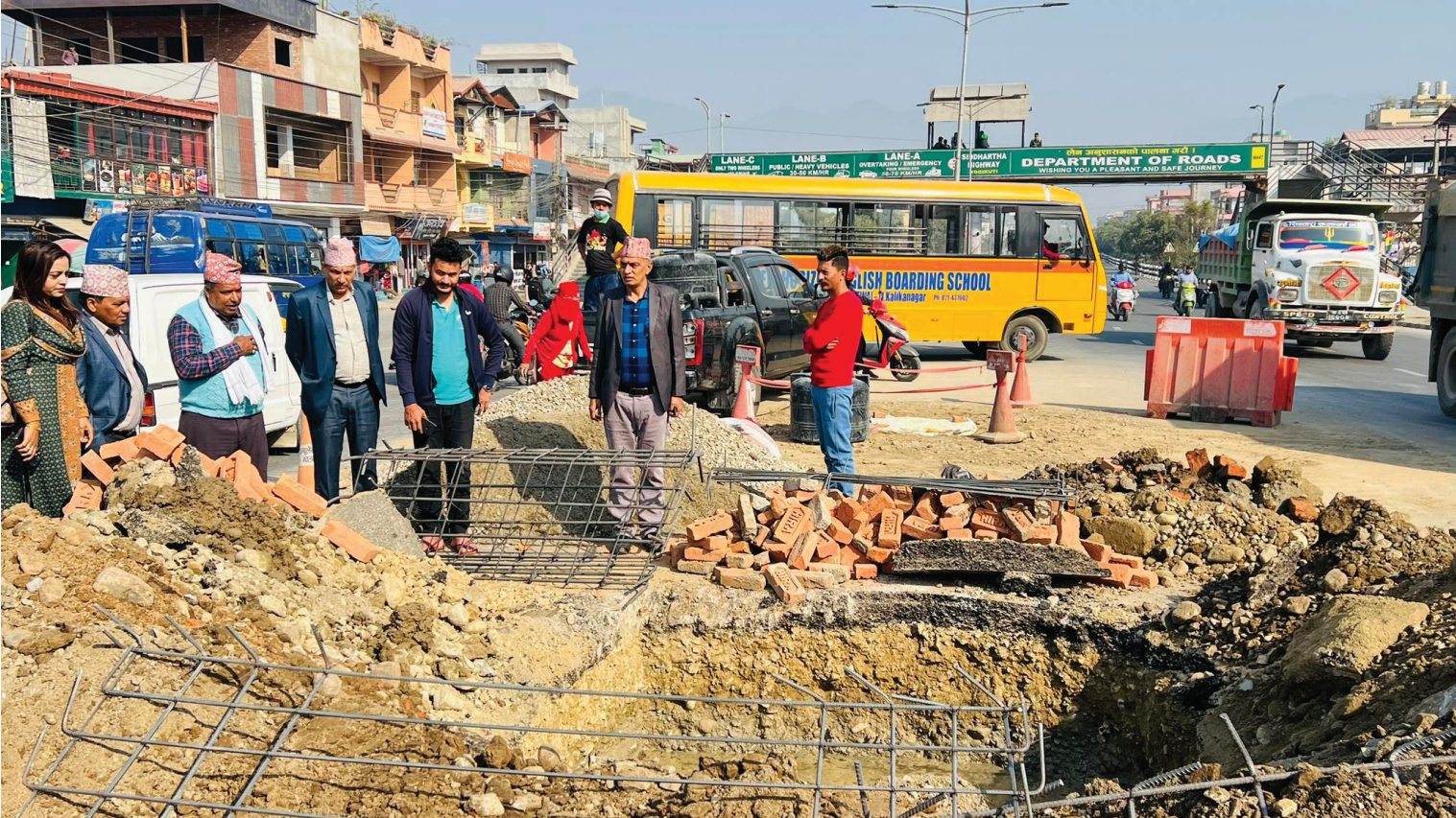
उज्यालो बुटवलको सपना: बुटवल र तिलोत्तमा नरपालिकाको सिमाना योगीकुटी क्षेत्रमा जडान गर्न लागिएको हाईमाक्स लाईटको पिलर ढलान कार्यको निरीक्षण गर्दै बुटवल उपमहानरपालिका नगर प्रमुख खेलराज पाण्डेय सहितका प्राविधिक टोली । बुटवल उपमहानरपालिकाले उज्यालो बुटवल बनाउने अभियान अनुसार चोक चोकमा उच्च क्षमता हाईमाक्स लाईट जडान गर्दै छ ।
